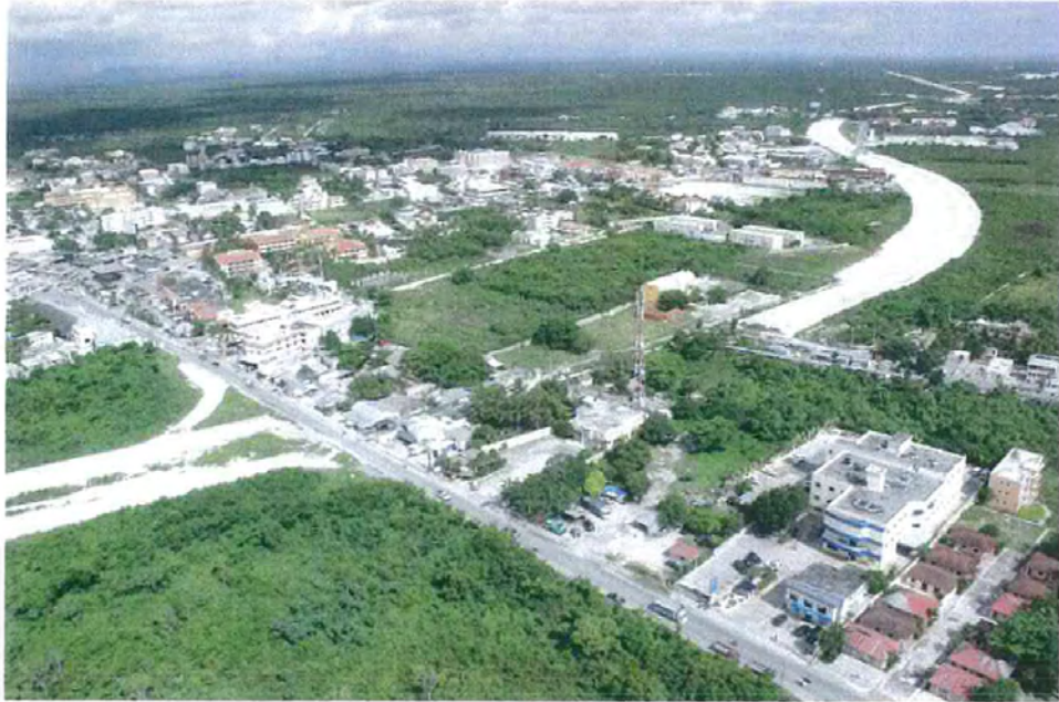
Vista aérea del área Friusa (20+300 al 20+700)
